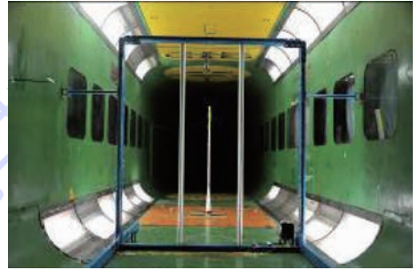
图6 风洞现场安装图
